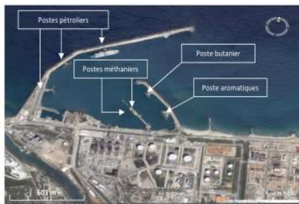
Figure11 : Photographie satellitaire montrant les infrastructures du nouveau port de Skikda (Google earth, 2014 modifiée)
