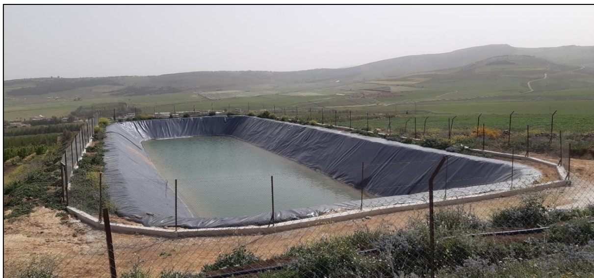
Figure 19 : Géomembrane de l'exploitation agricole : « Boulehlays »
