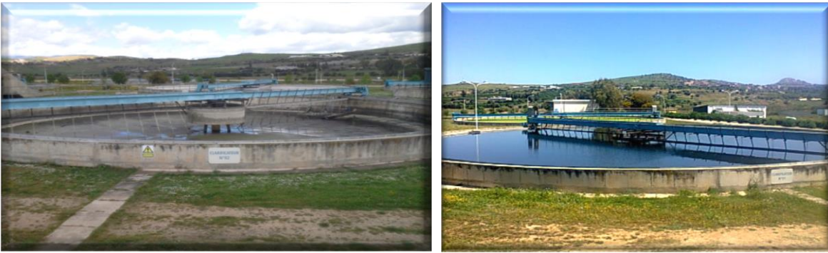
Photo II.5: Décanteurs secondaires
