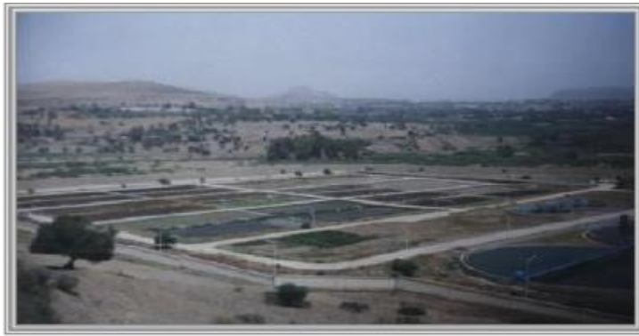
Photo II. 8: Lits de séchage.
