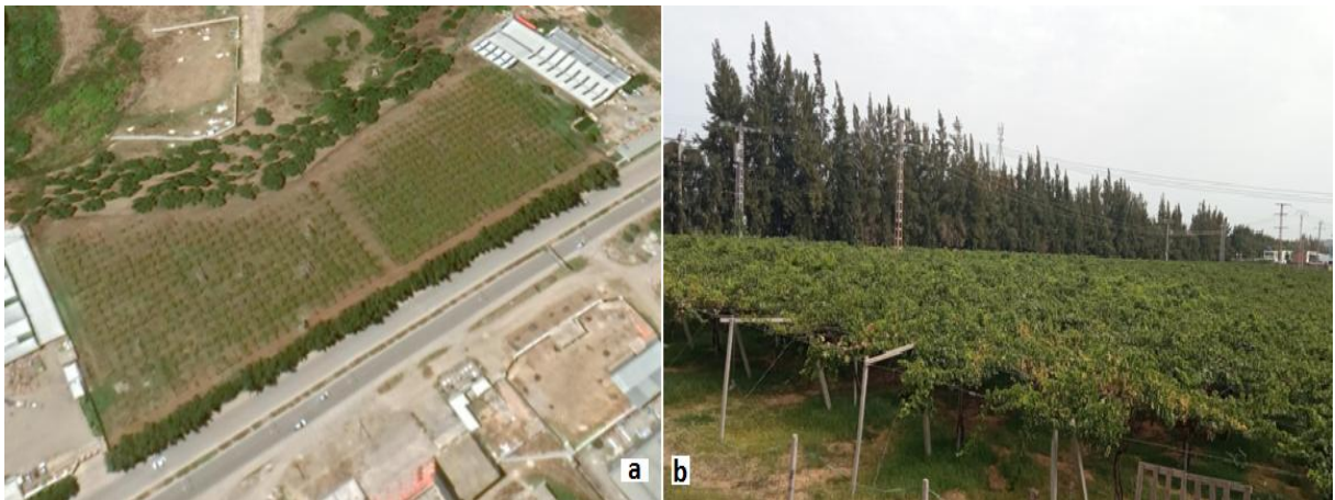
Figure n°12 : Photo satellite du vignoble de l'établissement Younes Abdallah (a: Google earth, 2021, b: Cliché Khebbab, 2021)
