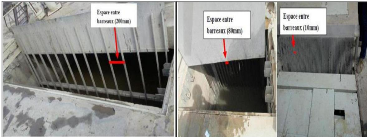
Figure 03 Types des dégrilleurs (Tekfi ,2006).
