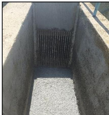
**Figure 11** Dégrilleur fin manuel.
