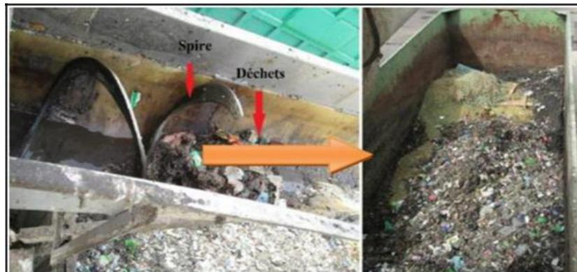
Figure 04 Evacuation de déchets vers les bennes de décharge (Tekfi ,2006).
