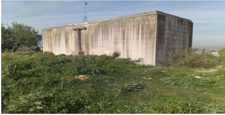
Figure 10 : Photo de Réservoir Base de vie.
