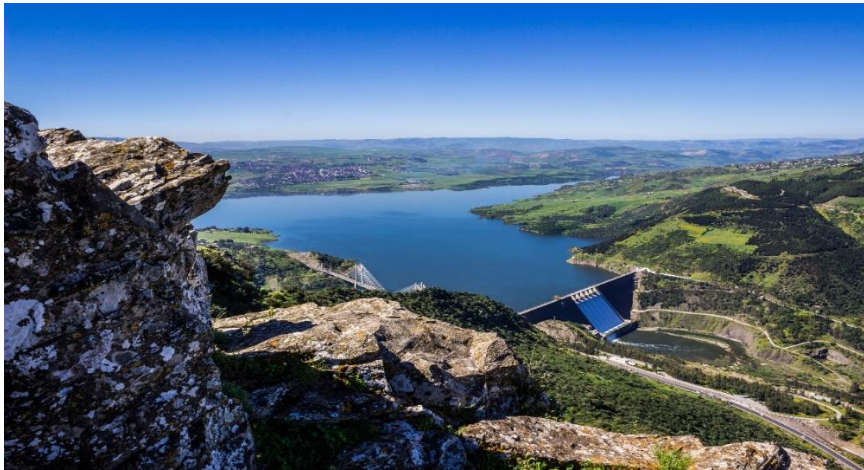
Figure 7 : Photo du barrage de Beni Haroun (Wikipédia)
