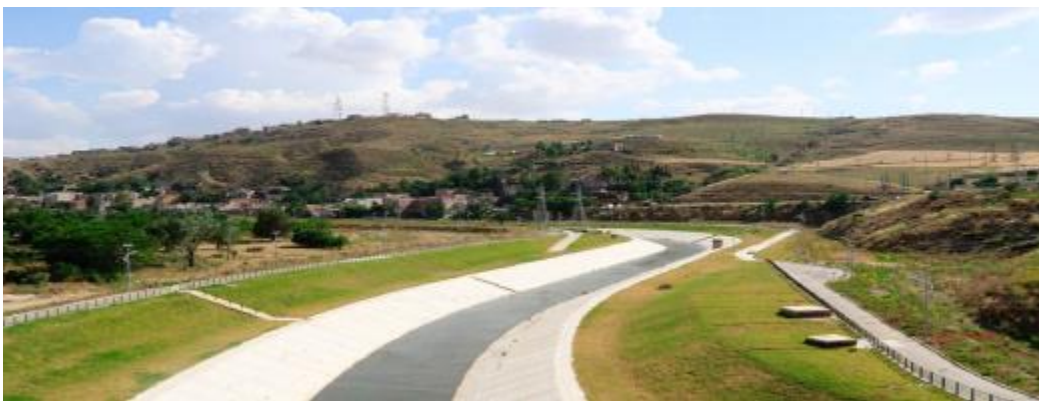
Photo 4 : Oued boumerzoug après les travaux de calibrage (PCPI, 2018)
