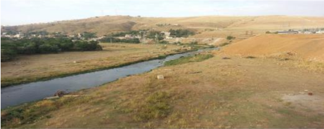
Photo3 : Oued boumerzoug avant les travaux de calibrage(PCPI ,2018)
