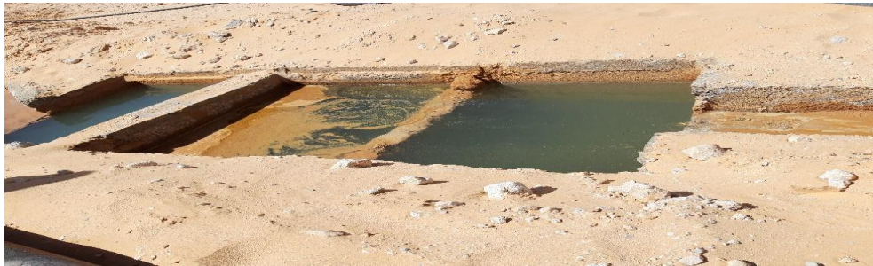
Figure 7 : Les trois compartiments du Skimmer. (Chouaoua & Idami le 7/4/2019)
