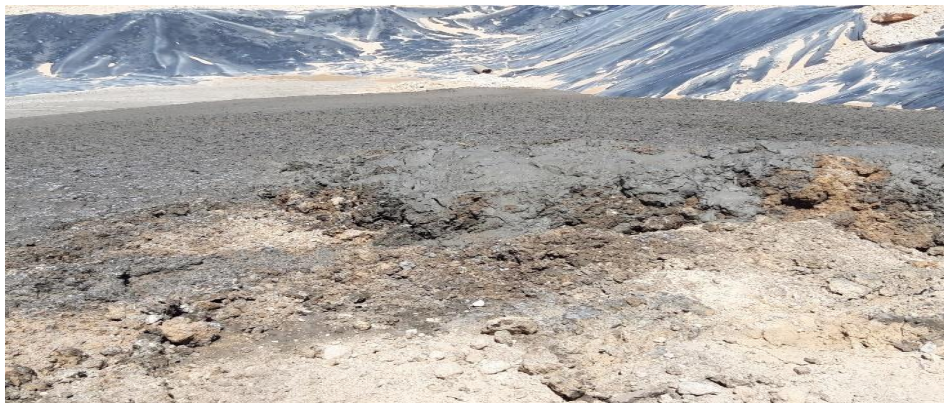
Figure 26 : bourbier pour le stockage des déblais traités
