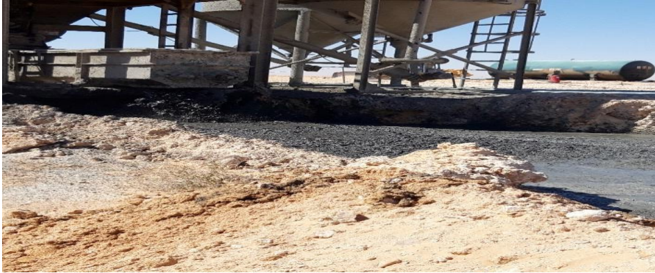
Figure 25 : fosse des déblais après solidification
