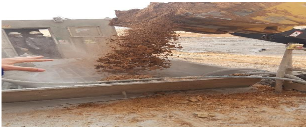
Figure 22 : décharge des déblais sur la grille de trémie
