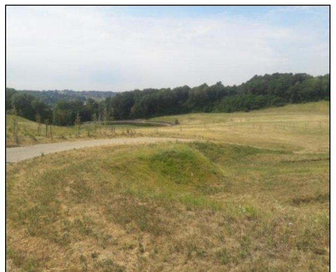
Casier saturé, fermé et réaménagé en espace vert au profit des citoyens du village limitrophe du CET
