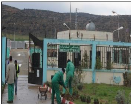
La déchetterie 13 ème Km.
