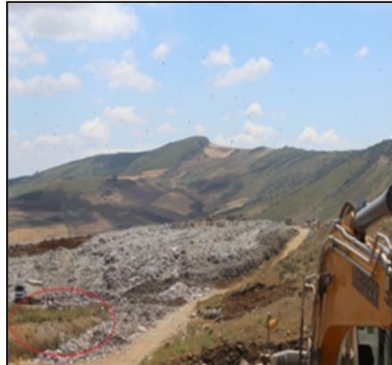
Décharge réhabilitée – Décharge saturée
