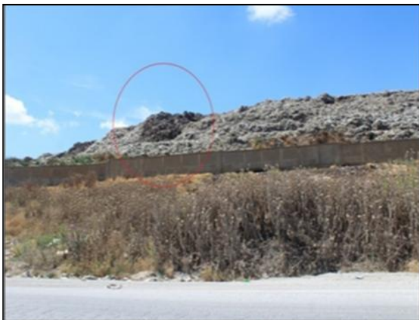
Instabilité des amas des déchets
