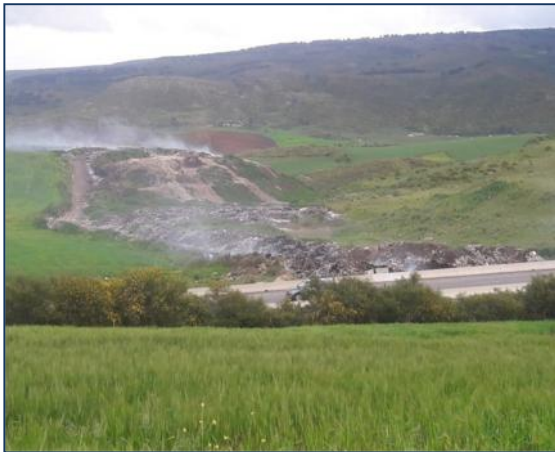
La décharge sauvage de Didouche Mourad
