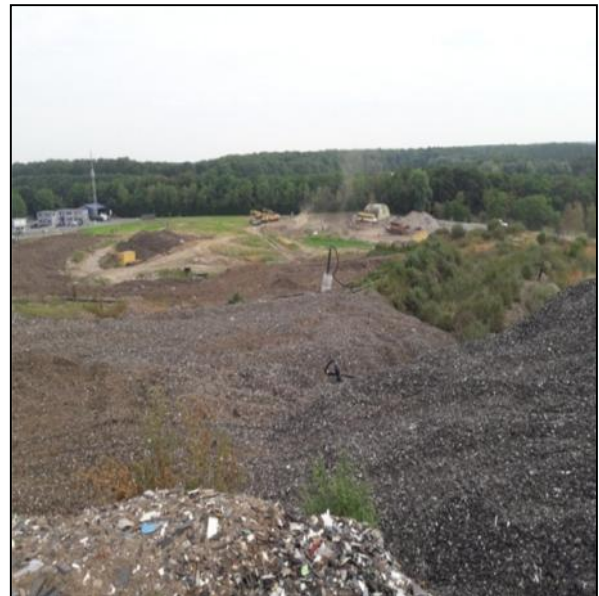
Lieu de déversement des déchets avec récupération des lixiviats
