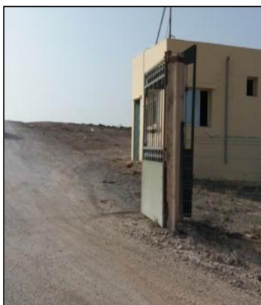
Entrée principale de la décharge des inertes
