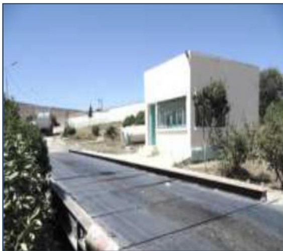
Loge et Pont bascule CET Boughareb.
