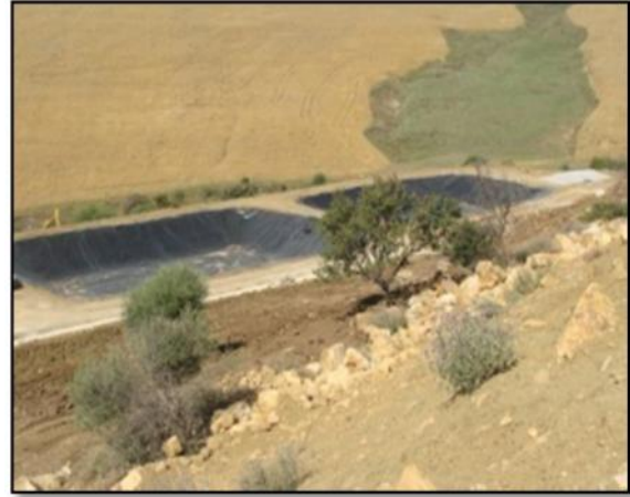
Les deux lagunes du CET
