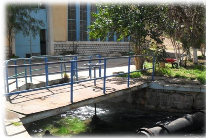
Figure 06 : station de pompage du Boumerzoug
