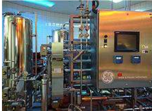
Figure 18 : Installation de nettoyage en place (N E P) dans la laiterie de Milalait
