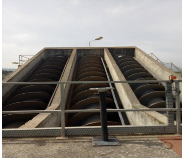
Photo 07: Pompes à vis de retour de boue_(STEP Ibn Ziad, Constantine, le 12/05/2019)
