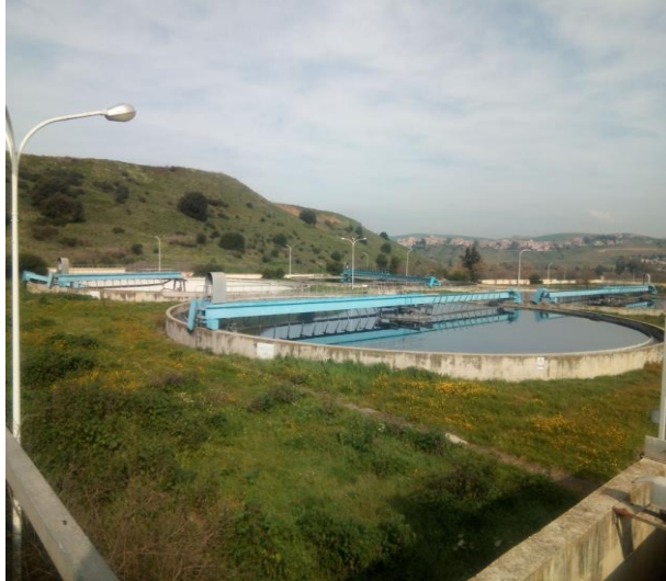
Photo 06 : Bassins d'aération_(STEP Ibn Ziad, Constantine, le 12/05/2019)
