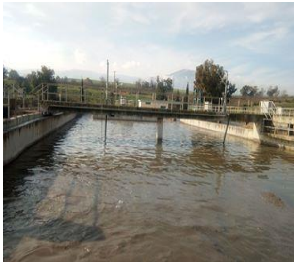
Photo 05 : Bassins d'anoxie (STEP Ibn Ziad, Constantine, le 12/05/2019)
