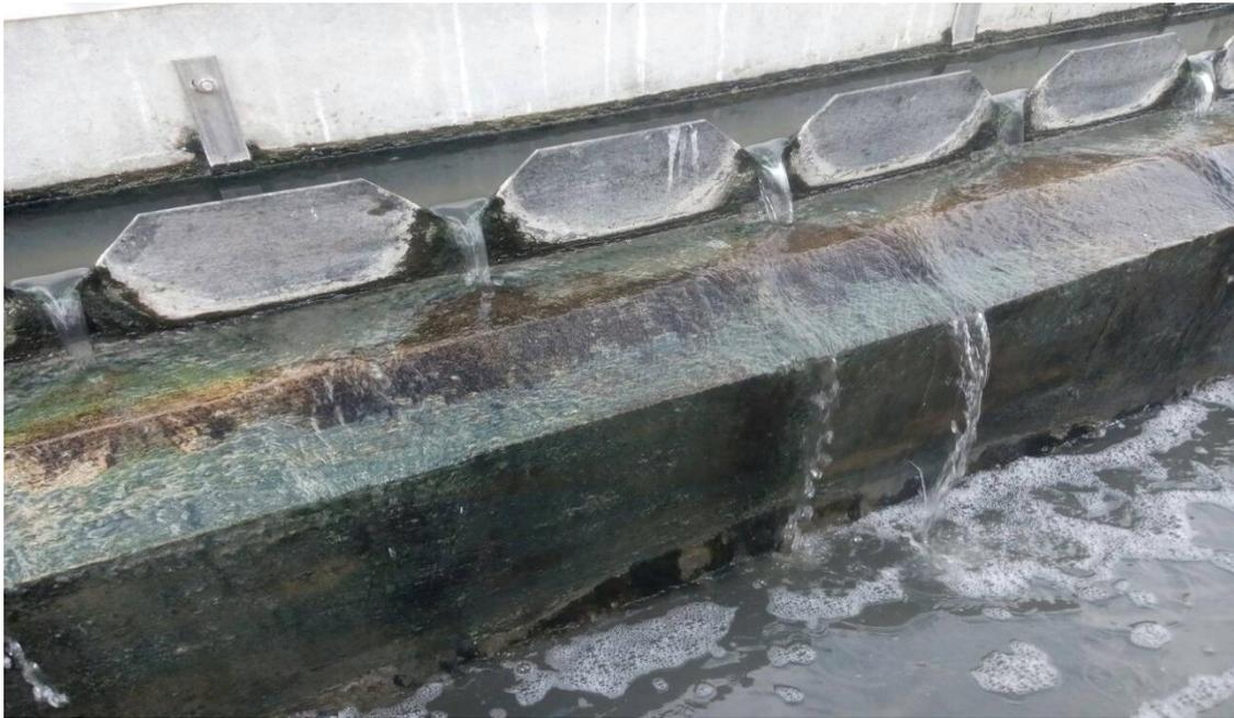
**Figure 1 :** la séparation physique des solides et des graisses des eaux usées par un clarificateur primaire.
