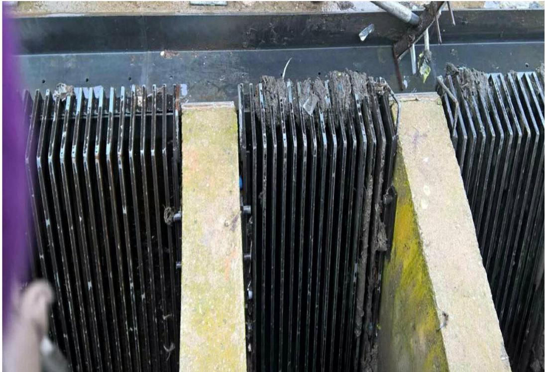
**Figure 3 :** un dégrilleur mécanique.
