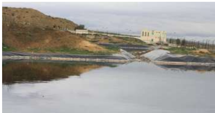
Photo 4 : les lagunes de lixiviat du C.E.T (2018)
