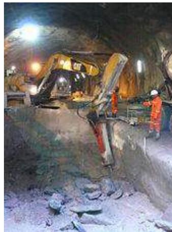
Un brise-roche hydraulique monté sur une **pelleteuse**. Un brise-roche hydraulique.
