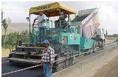
Un finisseur en cours d'application, on remarque le camion vidant sa benne d'enrobé dans la trémie
