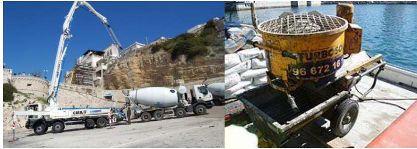
Fig.II.7. Pompe à béton
