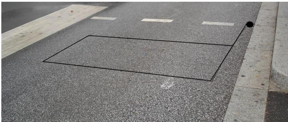
**Figure 2-6** : photographie d'une boucle électromagnétique simple. On distingue le trait de scie rectangulaire (la boucle elle-même) et le trait de scie rectiligne qui relie la boucle au générateur électrique et au détecteur de champ magnétique.
