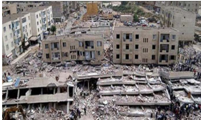
Fig. 13 : Séisme de Boumerdes [Photo prise par nos soins, 2003]
