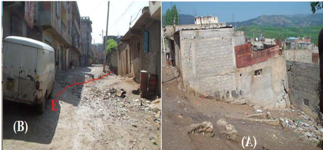
Fig. 25 : Glissement du quartier de Boudraa Constantine [BOU, 2007]
