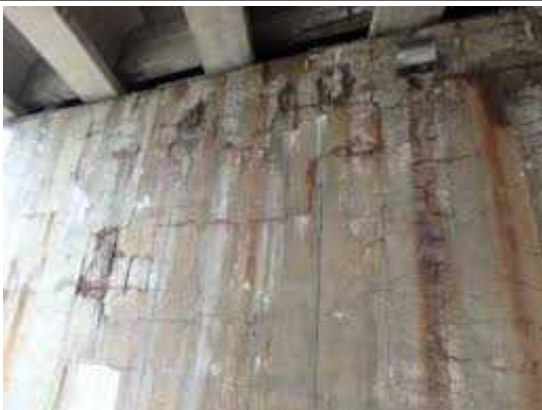
Figure 5.6 : exsudations blanches ou grisâtres au droit des fissures
