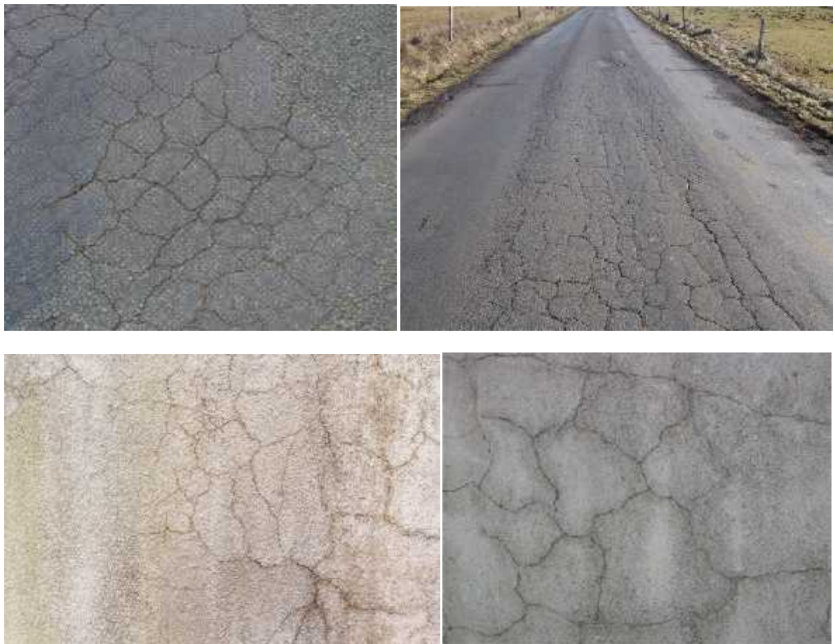
Figure 5.1 : attaque sulfatique produisant un faïençage des fissures dans les bétons et routes
