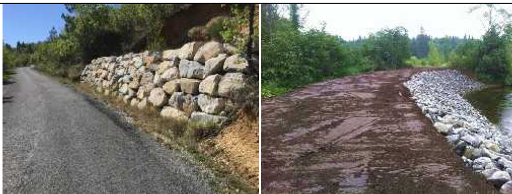
Figure 1.7 : Renforcement et stabilisation des talus de route et berge d'oued par enrochement
