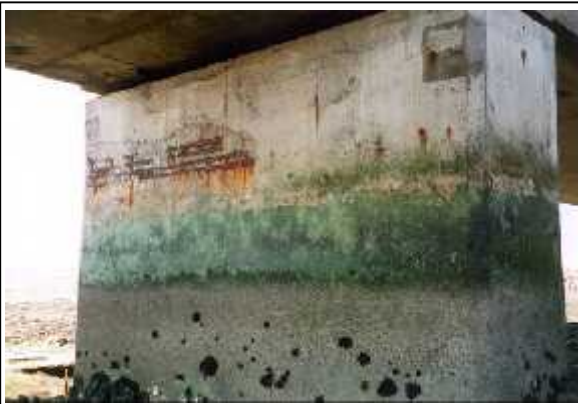
Figure 5.5 : coloration et décoloration des bétons le long e fissures
