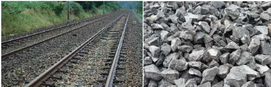
Figure 1.5 : Photos montrant l'utilisation des ballasts comme assises des voies ferrées
