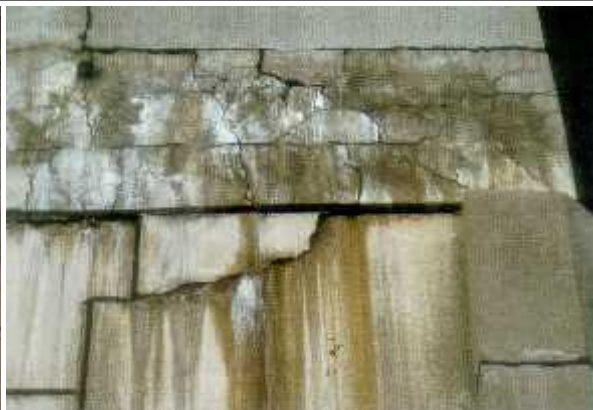
Figure 5.6 : exsudations blanches ou grisâtres au droit des fissures
