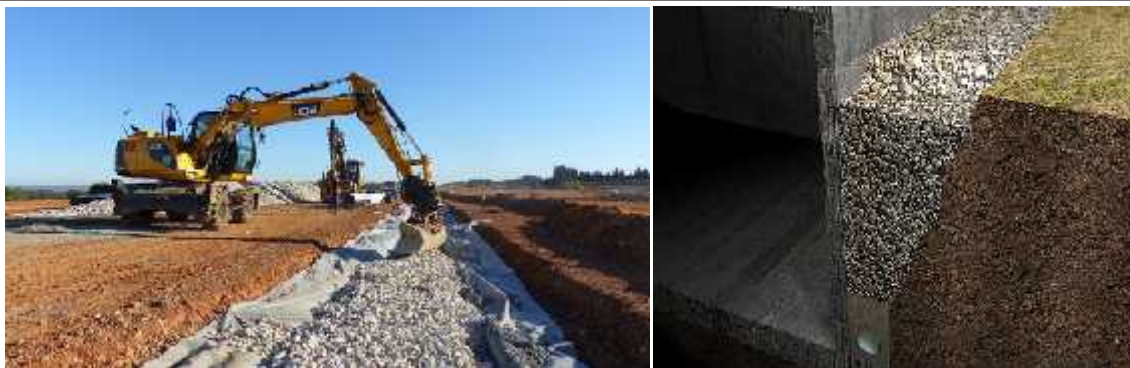
Figure 1.6 : Photos illustrant l'utilisation des granulats comme matériaux drainant
