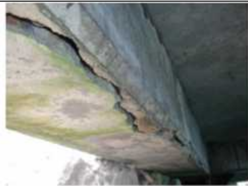
Figure 5.5 : coloration et décoloration des bétons le long e fissures
