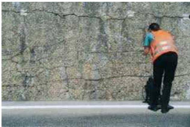
Figure 5.4 : fissuration orientée reproduisant le tracé des armatures dans le béton
