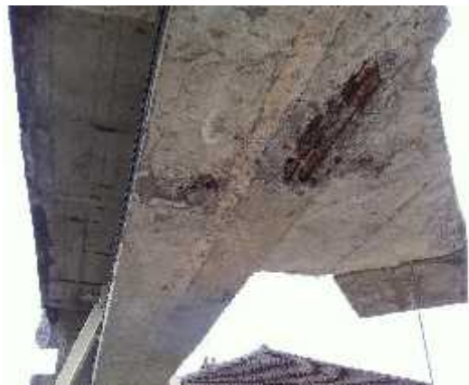
Figure 5.4 : fissuration orientée reproduisant le tracé des armatures dans le béton
