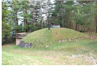
réservoir superficiel ou semi-enterré
