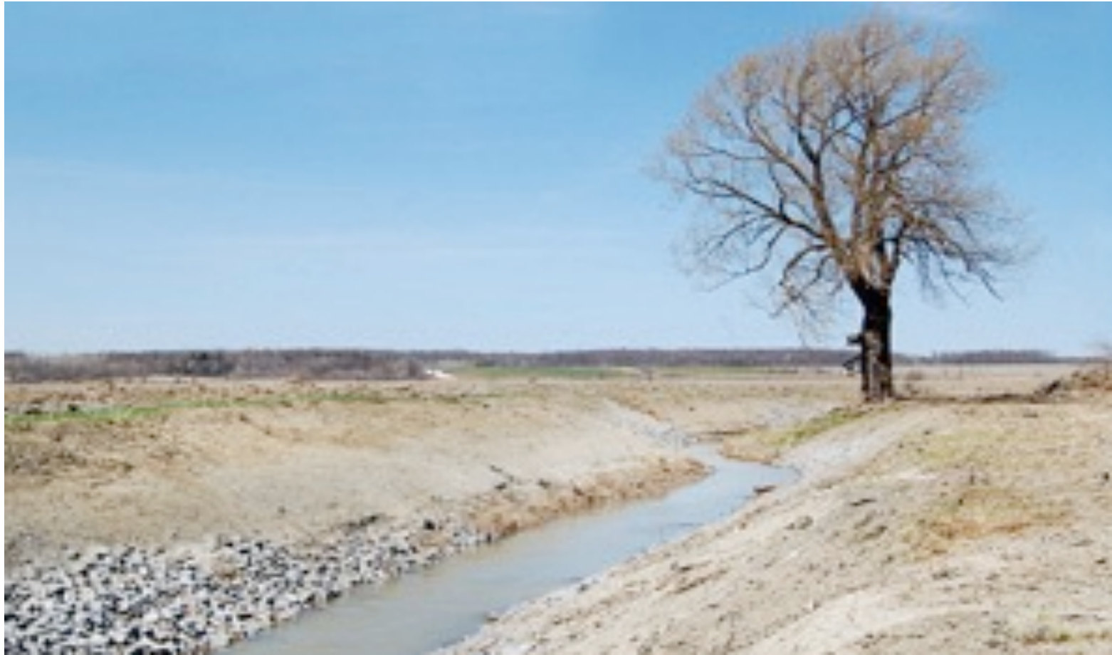
Stabilisation de berge à l'aide d'enrochement, printemps, peu après les travaux
