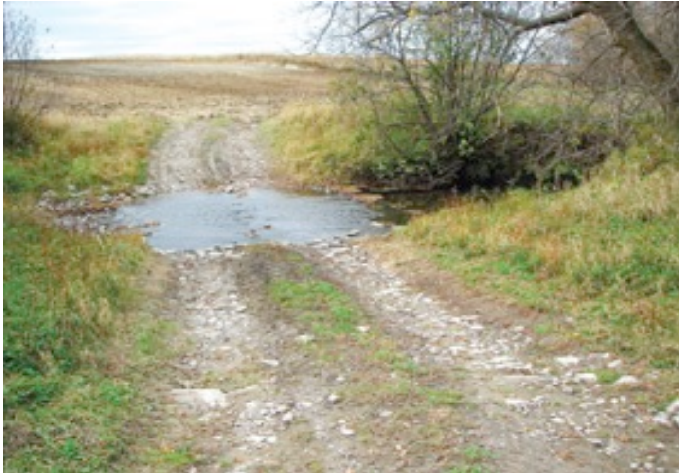
Traverse à gué aménagée.
