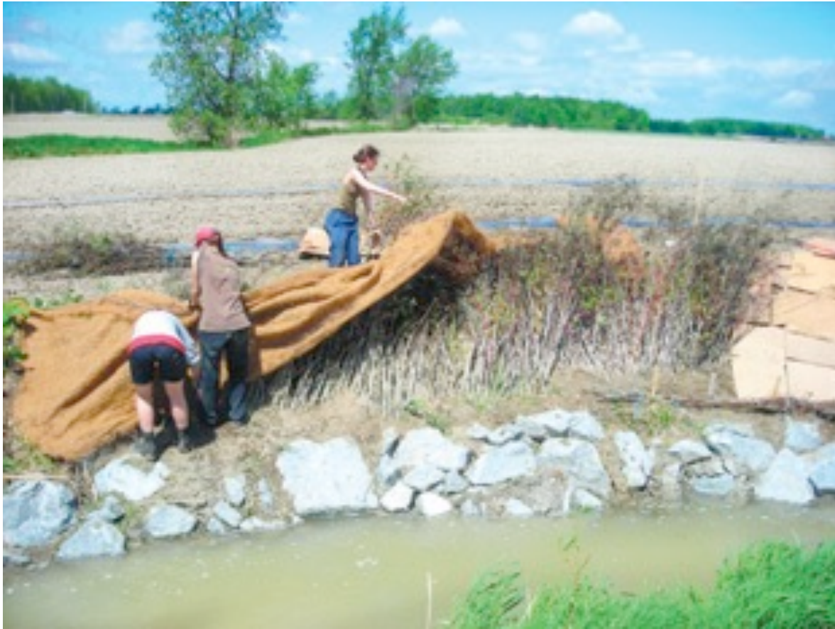
Végétalisation des berges à l'aide de matelas de branches.
