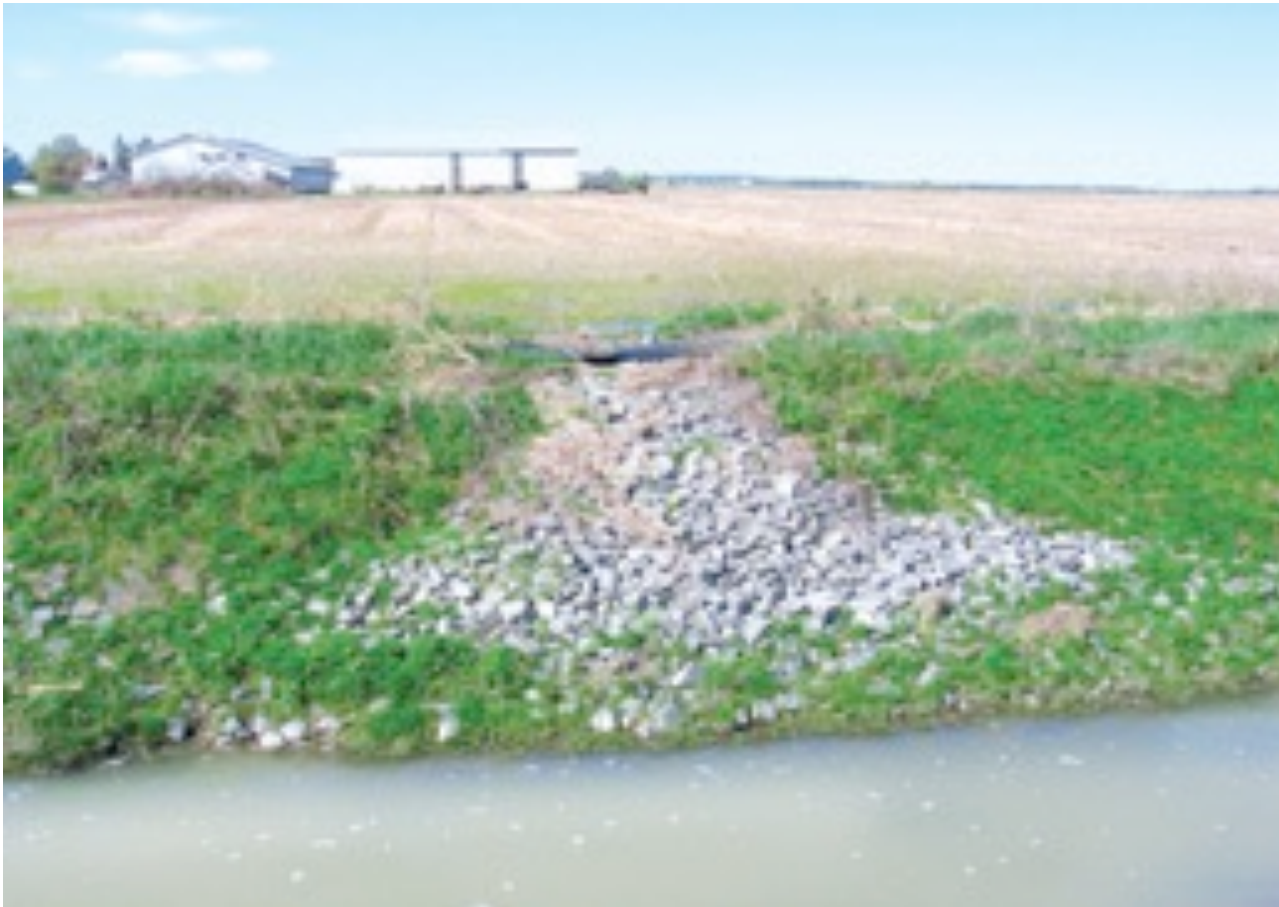
Chute enrochée aménagée pour solutionner ce problème d'érosion.
