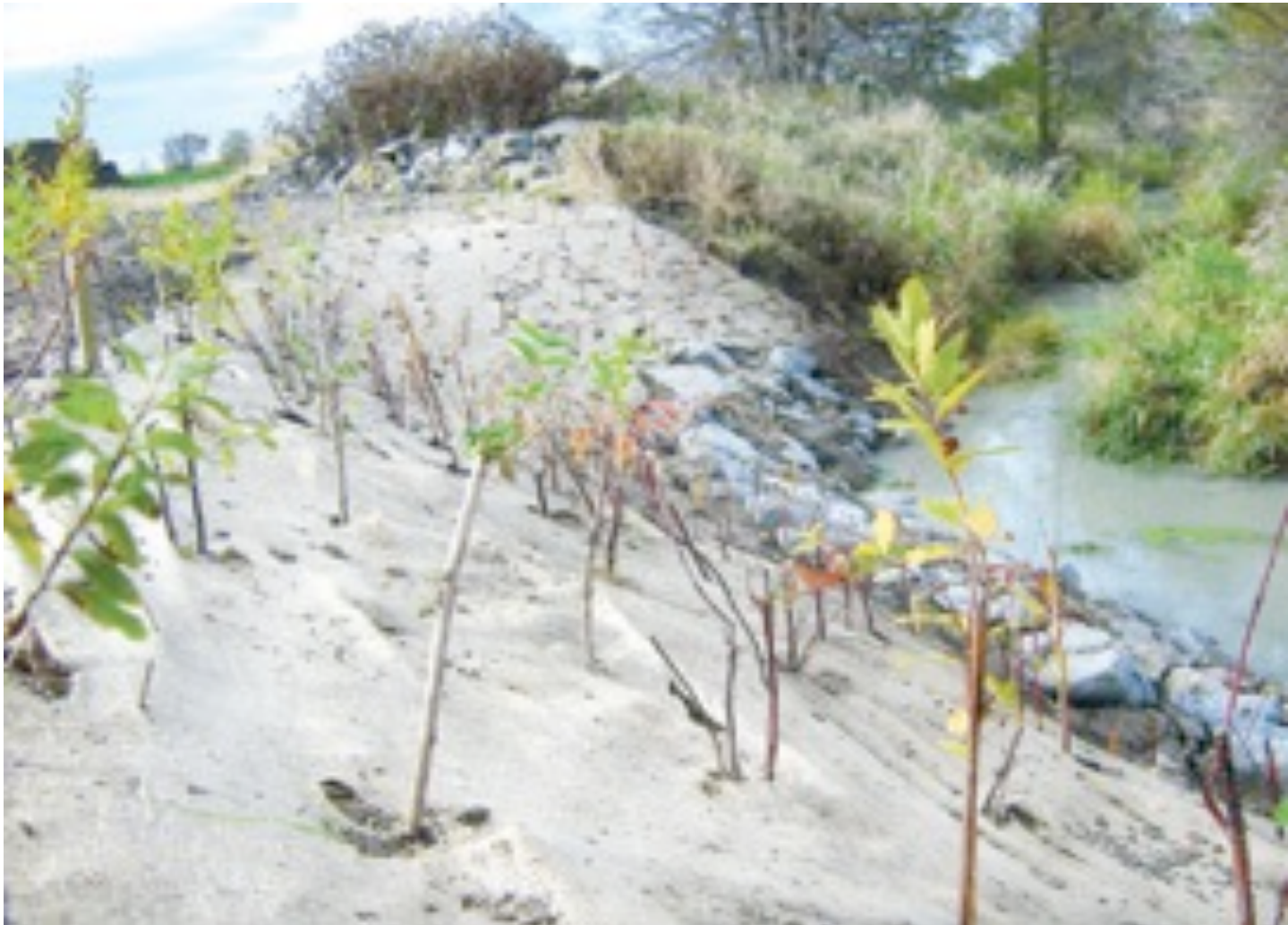
Végétalisation des berges à l'aide de paillis et d'empierrement.
