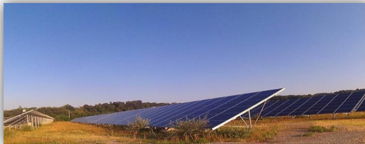
Figure 1 : Ferme solaire de 6MW sur terrain de 11 Ha dans la Drôme, en France, installée en 2011 (durée d'exploitation prévue : 30 ans) (Van den hende, 2018)
